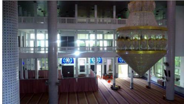
Rajah 4.0: Ruang Atrium di Masjid tidak mempunyai pembukaan di bahagian atas bumbung atau tepi kubah menyebabkan hawa panas tidak boleh dilepaskan keluar
