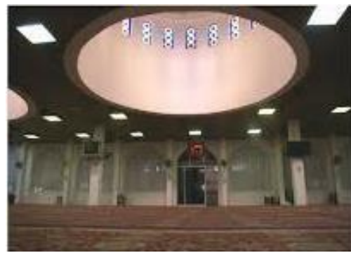
Rajah 3.12: Tingkap kaca bewarna kekal yang dipasang di dalam kubah baik untuk pencahayaan tetapi membawa bersamanya kepanasan ke dalam ruang dalaman masjid
