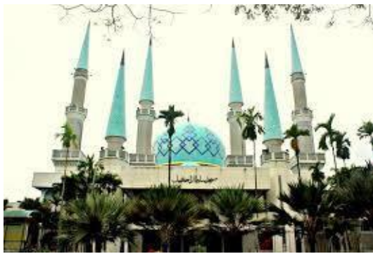
Rajah 3.11: Bumbung dan kubah Masjid yang dibina tidak mempunyai pembukaan untuk melepaskan udara panas yang terkumpul keluar dari ruang dalaman masjid
